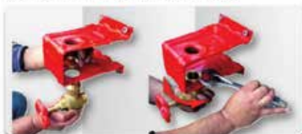
2/ Positionnement et fixation du robinet d'arrêt
